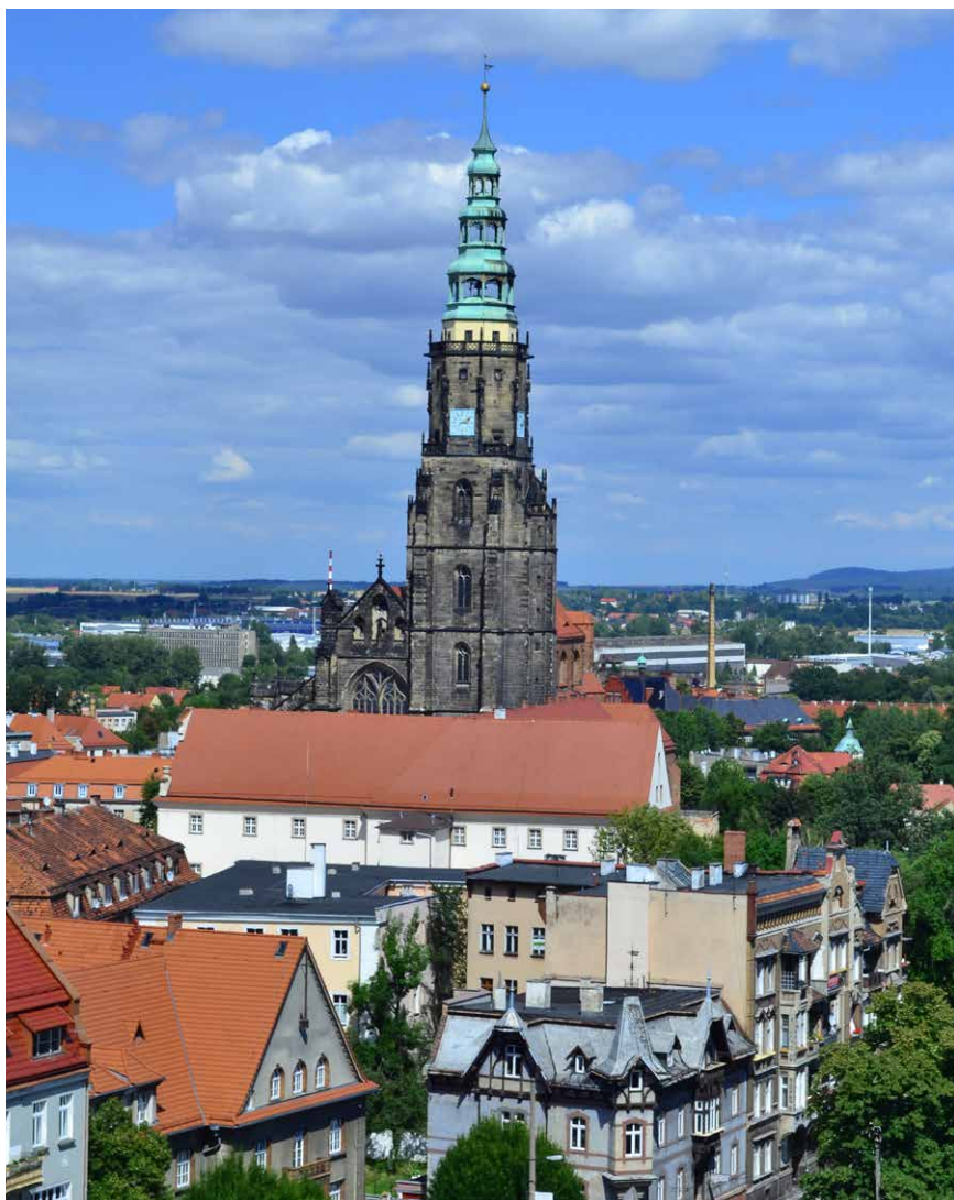
Świdnicka katedra – rzekomo w 1330 r. ks. Bolko II świdnicki miał położyć kamień węgielny pod tę budowlę Zdj. Mariusz Baricki
