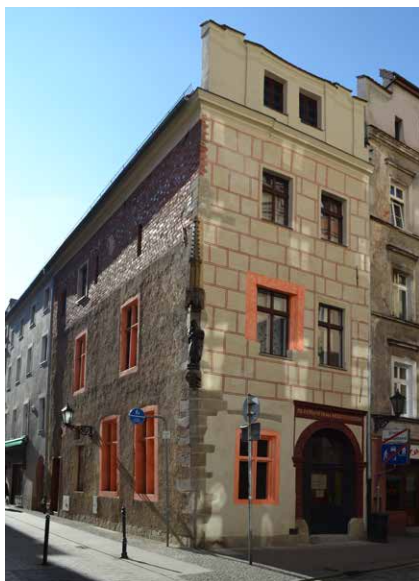
Narożna kamienica u zbiegu ul. Kotlarskiej i Łukowej. Zgodnie z legendą sięgającą czasów Bolka II jej piwnice zamieszkiwać miał bazyliszek Zdj. Mariusz Barcicki
